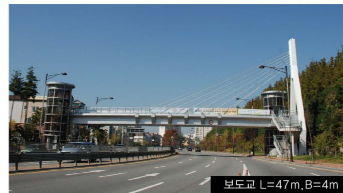
5 화성동탄지구 택지조성 관리공사(시범단지)
