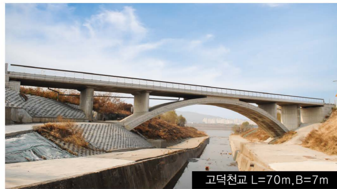
1 암사취수장~하남시계간 자전거도로 연결공사
